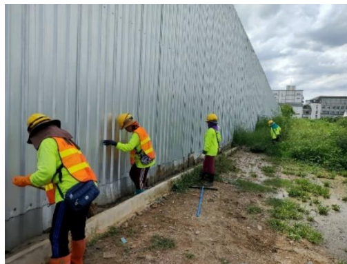
รูปที่ 20 การขุดลอกรางระบายน้ำ
