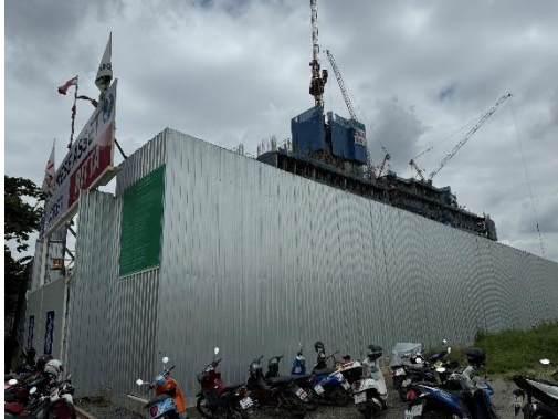
รูปที่ 1 รั้วทึบชั่วคราว (Metal Sheet) ความสูง 6 เมตร รอบพื้นที่โครงการ
