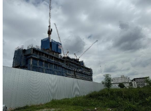
รูปที่ 1 รั้วทึบชั่วคราว (Metal Sheet) ความสูง 6 เมตร รอบพื้นที่โครงการ
